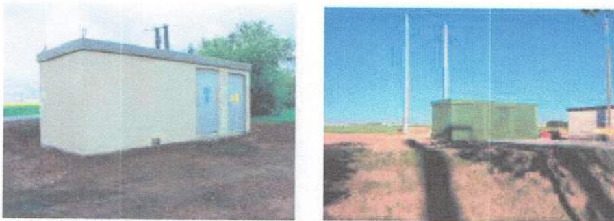
Photographie 2 : Exemples de postes de livraison
